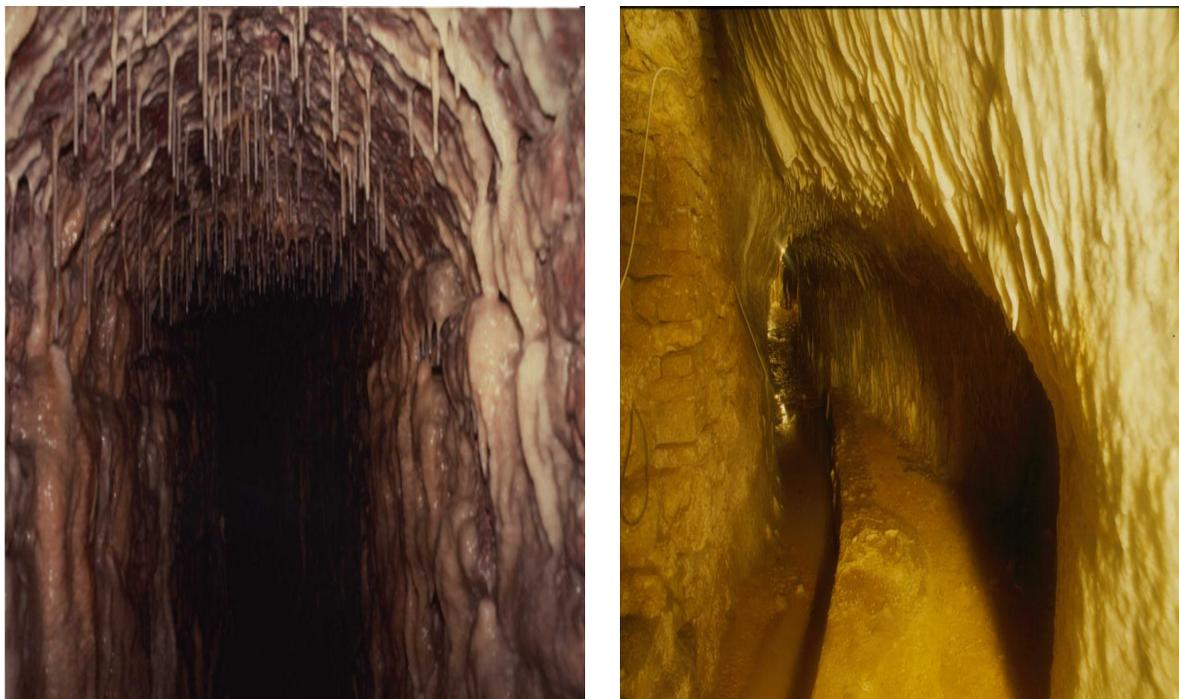
Fig. 8 cunicoli completamente ricoperti da concrezioni calcaree
