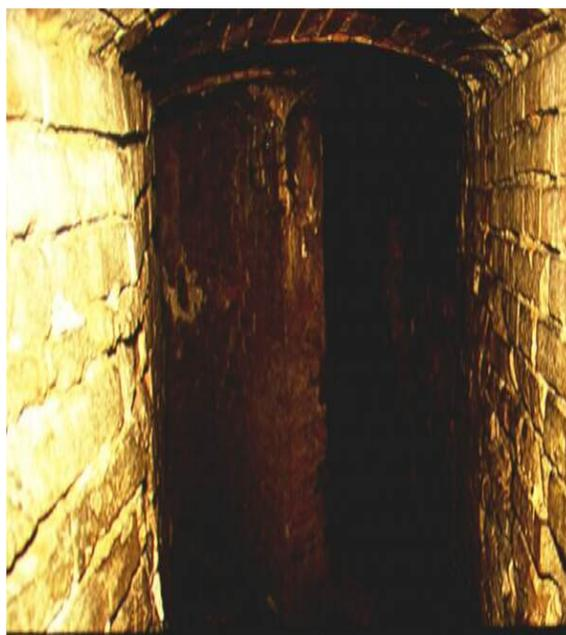
Fig. 7 interno dei cunicoli : privi di rivestimento e con rivestimento in laterizio
